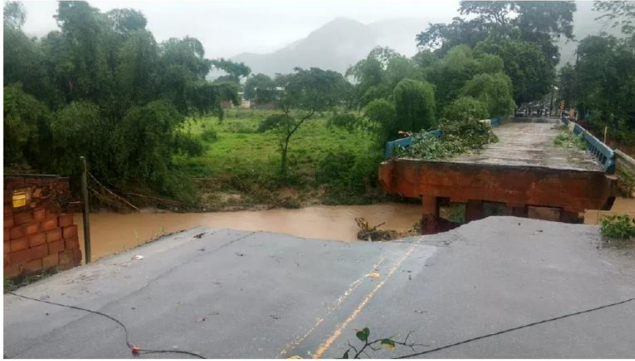
Figura 22 - Parte da ponte de Trapiche que desabou no dia 08 de novembro de 2018. Fonte: G1 - Foto: Paulo Henrique Cardoso/InterTV RJ.
